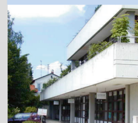
Außenstelle Eichthalstraße „Post“
