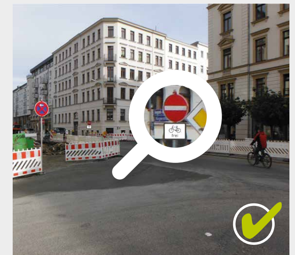
Bild 2 | Arbeitsstellenbedingte Einbahnstraße für Radverkehr freigegeben
