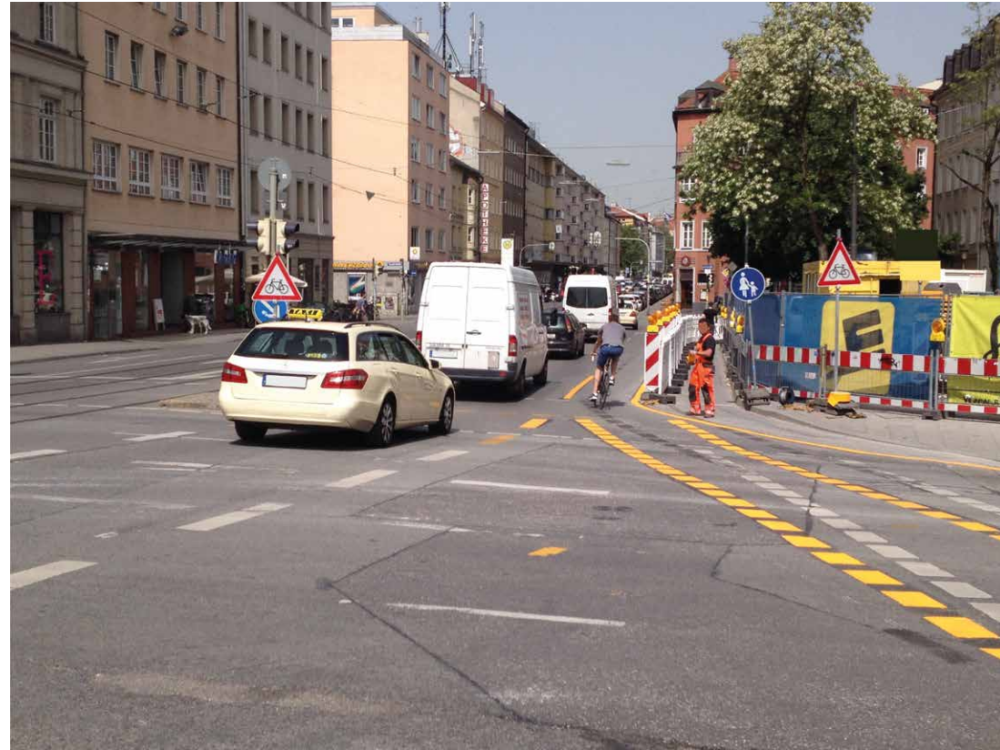
Bild 11a | Deutlich erkennbare Einleitung Radverkehr vom Radweg zur Fahrbahn an einem Knotenpunkt
