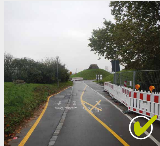
Bild 4 | gut sichtbare Absperrung und Gelb-Markierung
