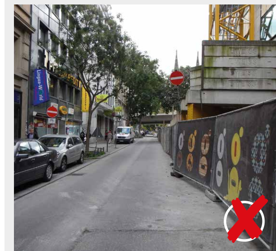
Bild 1 | Arbeitsstellenbedingte Einbahnstraße nicht für Radverkehr freigegeben
