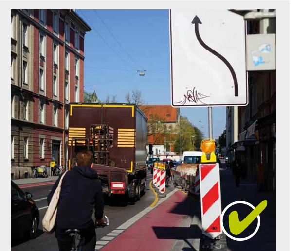
Bild 15 | Arbeitsstelle auf Radfahrstreifen durch Abspernung gesichert
