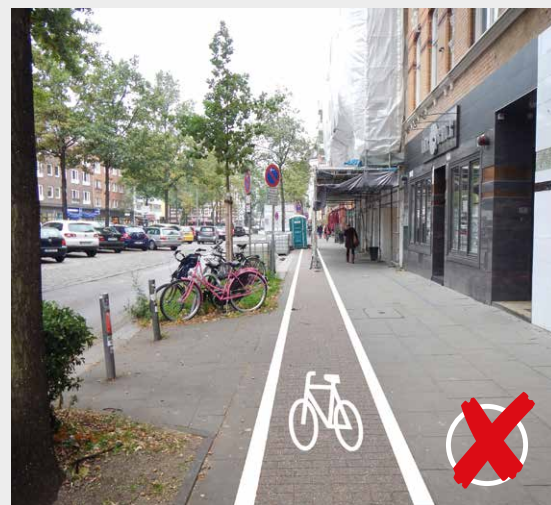
Bild 12 | Gerüst auf Radweg mit schlecht sichtbarer Sicherung
