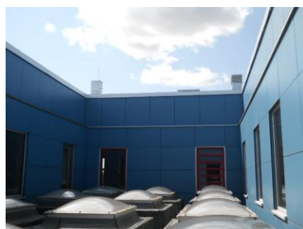
Fassade Lichthof im Atrium
