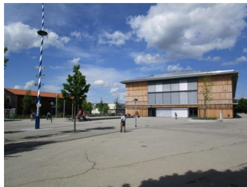
Dominik-Brunner-Realschule Poing mit Dreifachturnhalle (PPP-Projekt)
