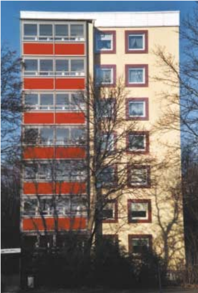
Ansicht vom Innsbrucker Ring, Südseite
