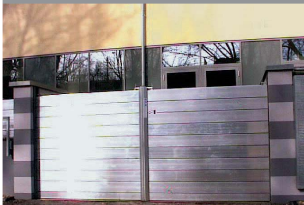
Umlaufender Hochwasserschutz mit teilmobilen Schutzelementen
