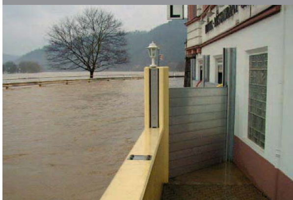
Umlaufender Hochwasserschutz mit teilmobilen Schutzelementen
