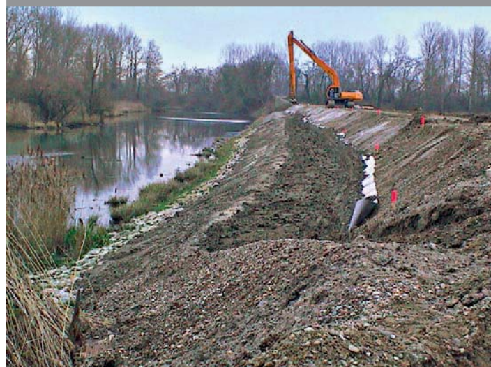
Hochwasserschutzdeich im Bau
