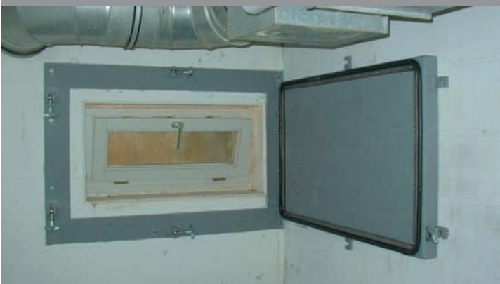
Druckdichter Fensterverschluss
