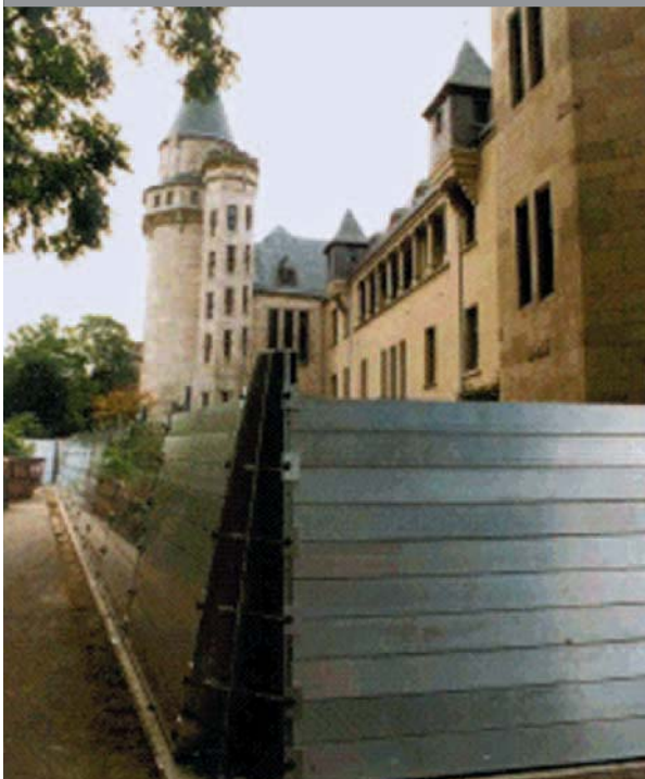
Mobiler Hochwasserschutz mit Dammbalken
