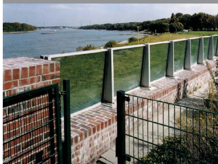
Hochwasserschutzwand mit Sicherheitsglas
