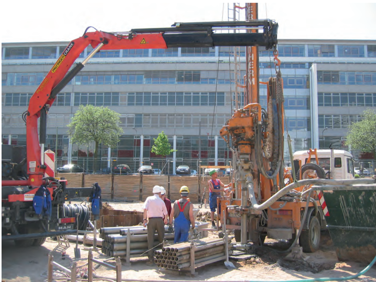
Abb. 2: Bohrung für Erdwärmesonden (Quelle: BWP)
