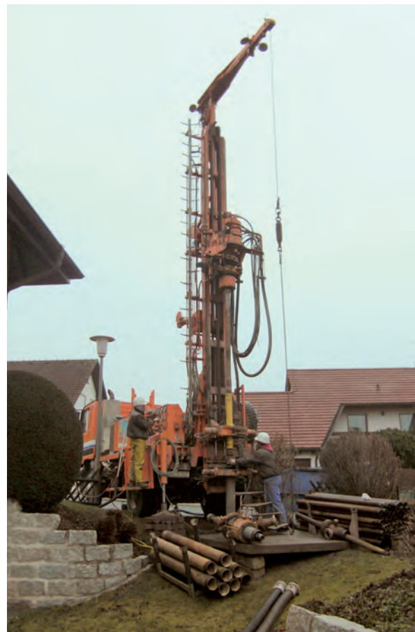
Abb. 1: Bohrung für Erdwärmesonden (Quelle: LfU)
