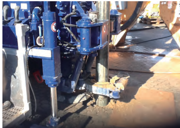
Abb. 6: Bohrung für eine Erdwärmesonde (Quelle: BWP)
