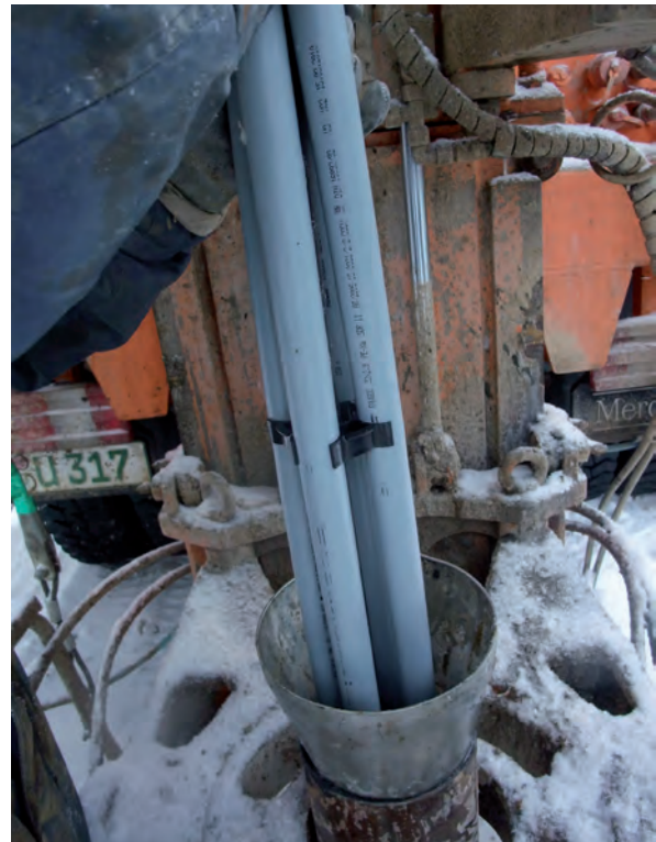
Abb. 8: Einbringen einer Erdwärmesonde mit Innenabstandshalter (Quelle: LfU)
