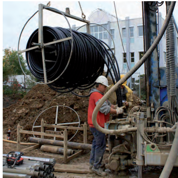
Abb. 7: Einbringen einer Erdwärmesonde (Quelle: LfU)
